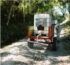
Una vez conformada la carpeta de rodamiento con el terreno natural, o si se realiza revestimiento del camino con material selecto o balasto, se procede a humedecer
