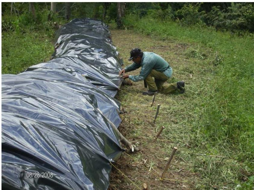
Figura 11. Plástico sujetado a estacas de madera con lazos de cordel o material de amarre.
