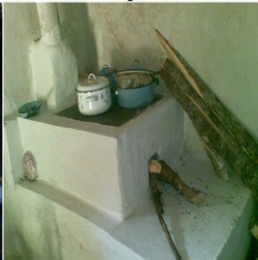
Estufa ecológica construida con el proyecto, reduce hasta en 70% el consumo de leña
