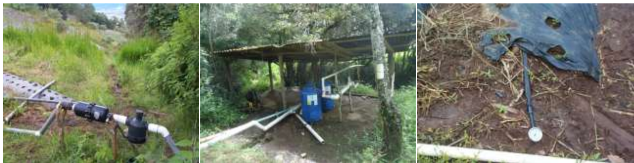
Figura 22. Izquierda: Filtros de disco; Centro: y filtros de arena para limpiar aguas de riego. Derecha: se presenta un manómetro para medir la presión del agua en el sistema.
