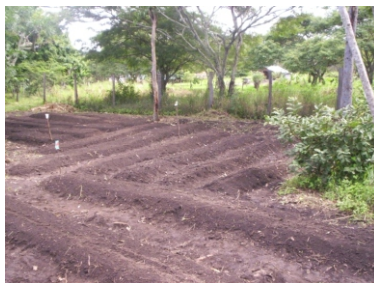
Remoción de terreno
