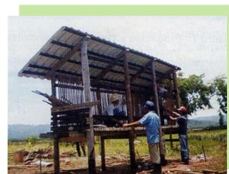
Las paredes y el piso son elevados para evitar el acceso de los roedores al grano. El techo puede construirse de materiales como lámina, tejas o madera. La decisión del tipo de material y las dimensiones de la troja dependerá de las posibilidades económicas del productor y su necesidad de almacenamiento. Las recomendaciones son similares a las de la troja tradicional con manejo mejorado.
